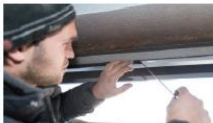
12 APLICARE IL NASTRO ISOLANTE
